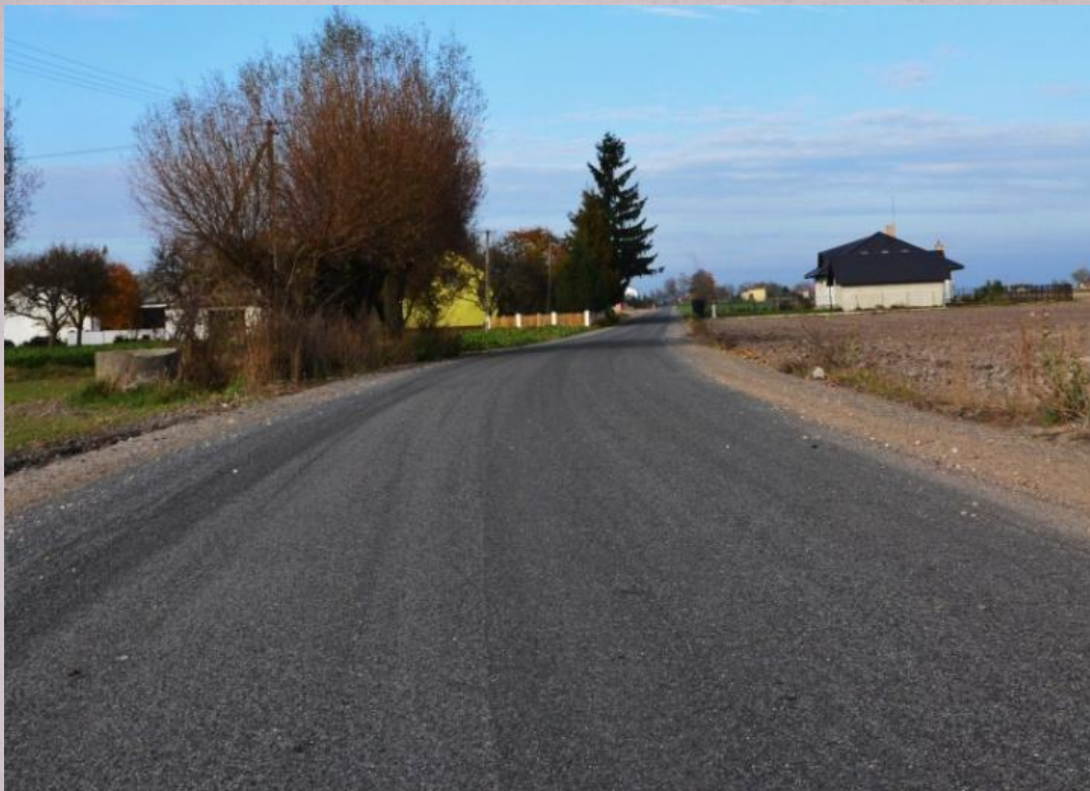
Wyremontowana droga gminna w Łążynie II
