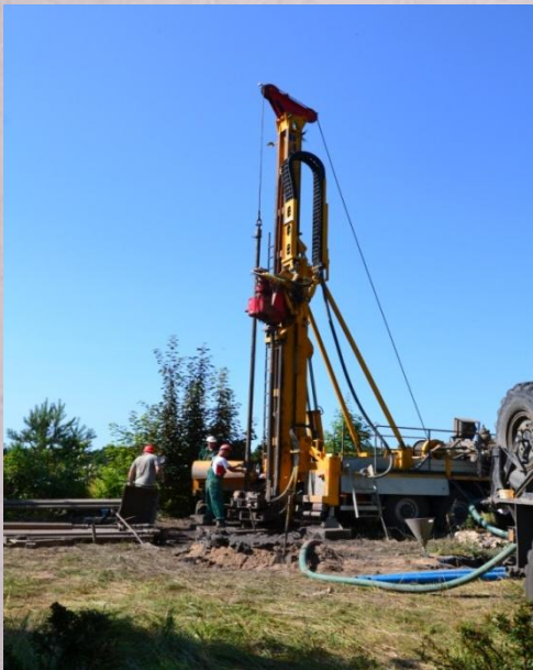
Budowa studni głębinowej w Zawalach
