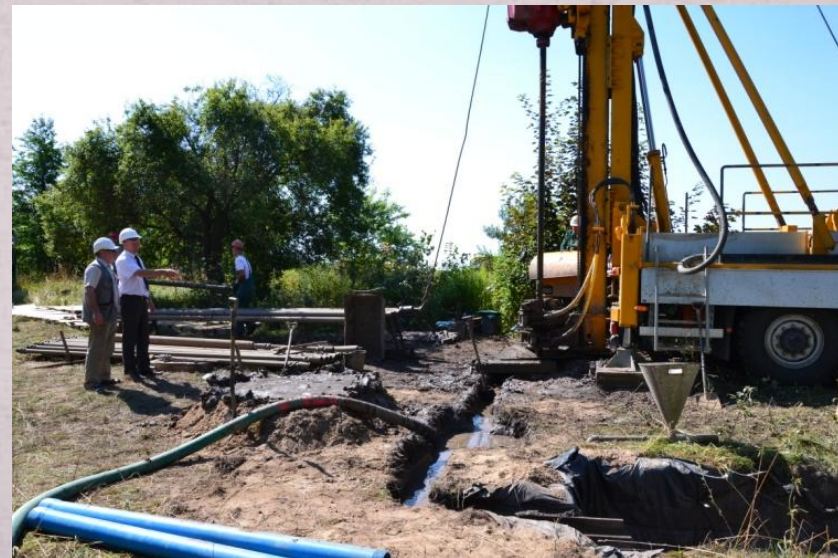
Budowa studni głębinowej w Silnie
