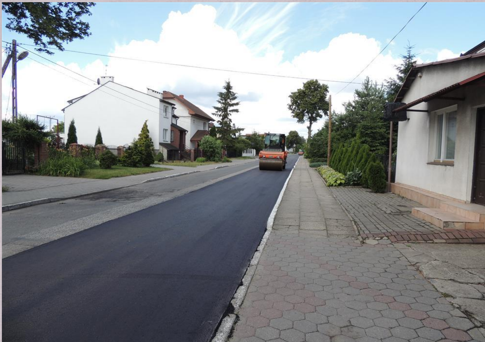
Wyremontowanie drogi gminnej w Obrowie
