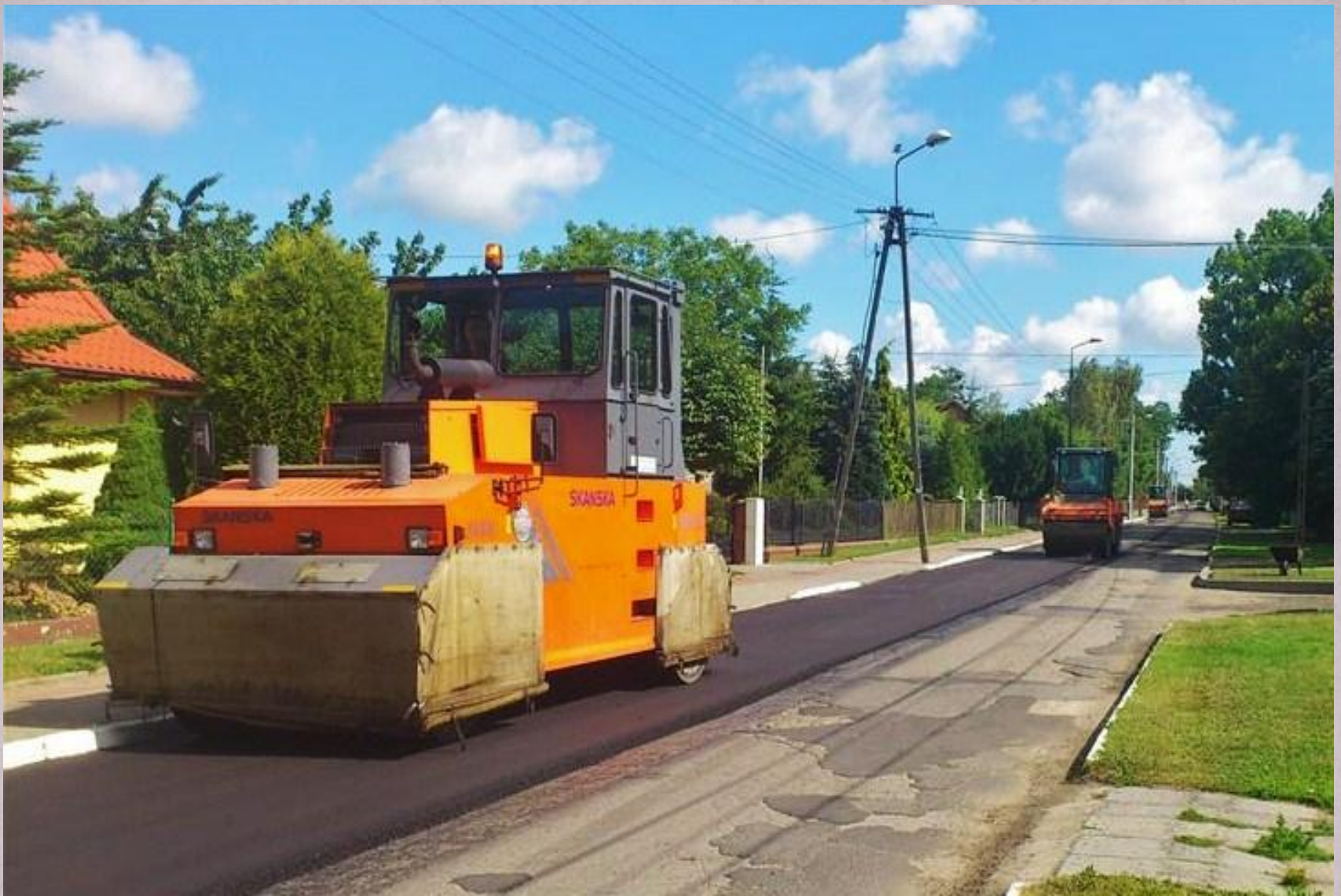
Wyremontowana droga w Dobrzejewicach
