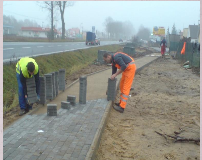
Budowa chodnika w miejscowości Głogowo
