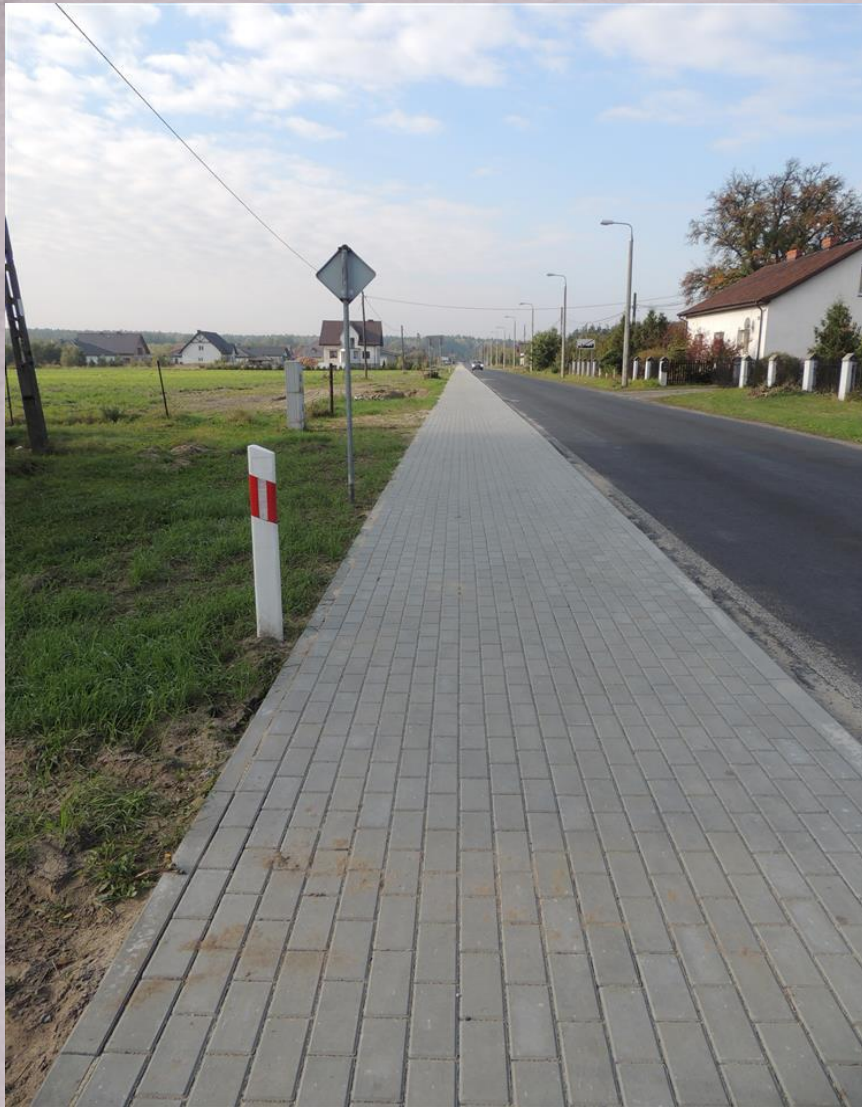
Budowa chodnika w ciągu drogi wojewódzkiej w Obrowie
