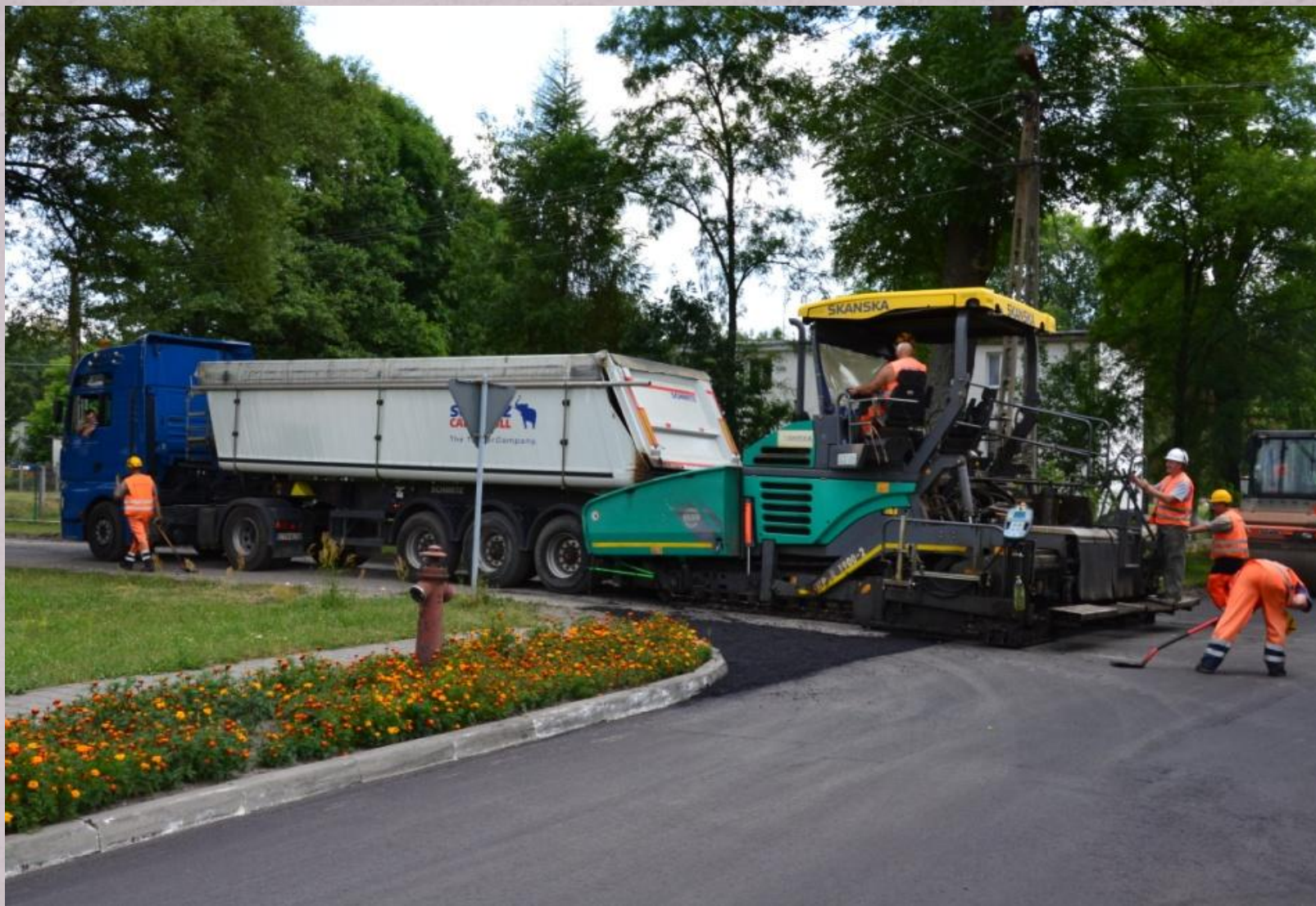
Wyremontowanie drogi gminnej w Osieku n/Wisłą
